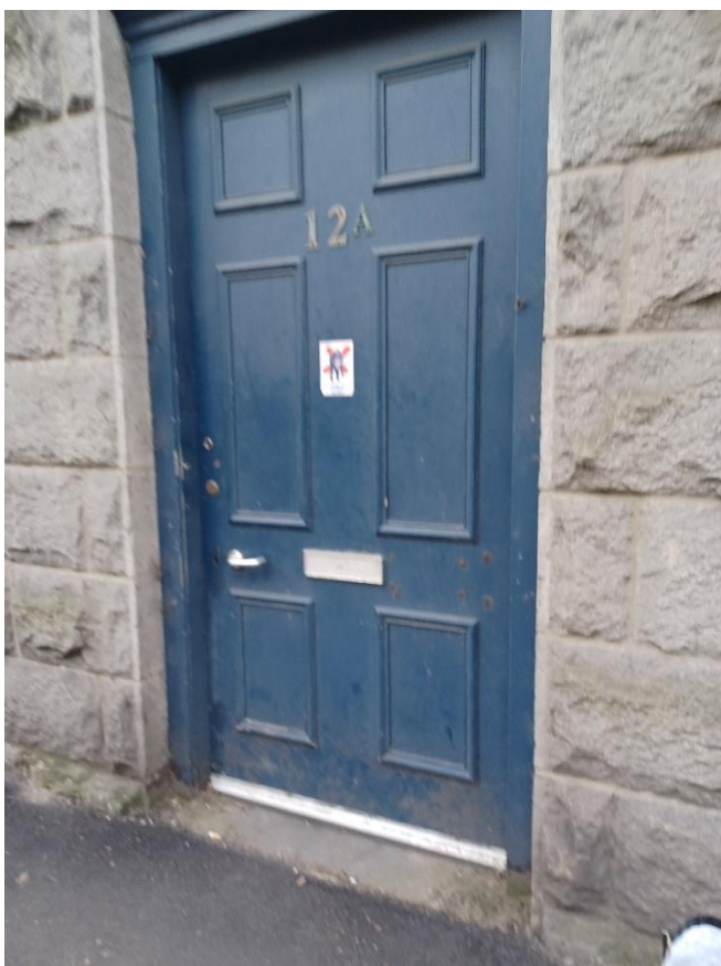
4. Existing door no. 3
