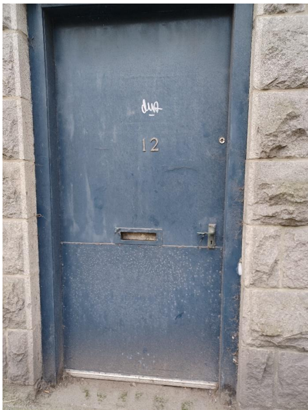
3. Existing door no. 2
